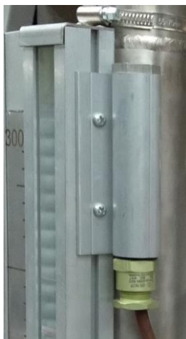
Рисунок 2. Монтаж сигнализатора на НБК
